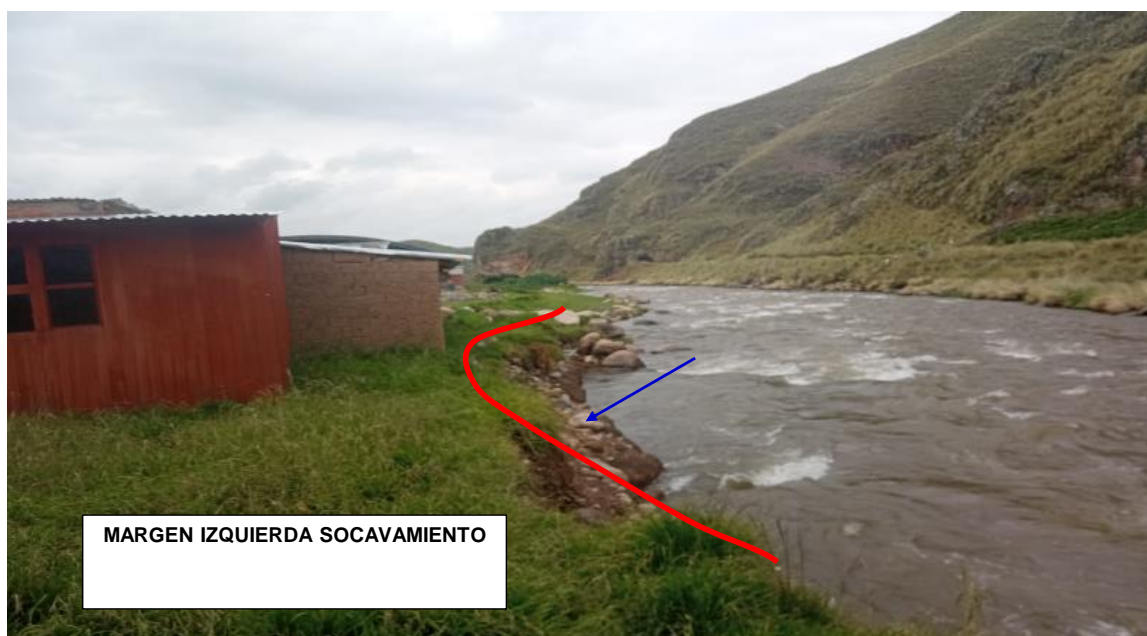
FIGURA N° 01: TRAMO CRÍTICO EN LA QUEBRADA CHAYCHAPAMPA, PARTE BAJA CON SOCAVAMIENTO EN LA MARGEN IZQUIERDA
