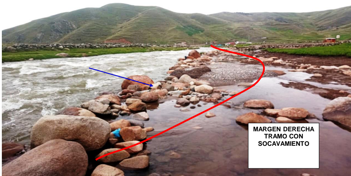
FIGURA N°03: EN LA TEMPORADA DE MAXIMAS AVENIDAS, LA QUEBRADA CHAYCHAPAMPA EROSIONA EN LA PARTE PLANA DEL TRAMO CON SOCAVAMIENTO.
